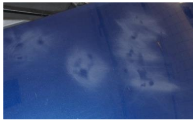
Schade als gevolg van reinigen met 'schuurspons'
