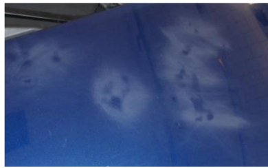
Schade als gevolg van reinigen met 'schuurspons'
